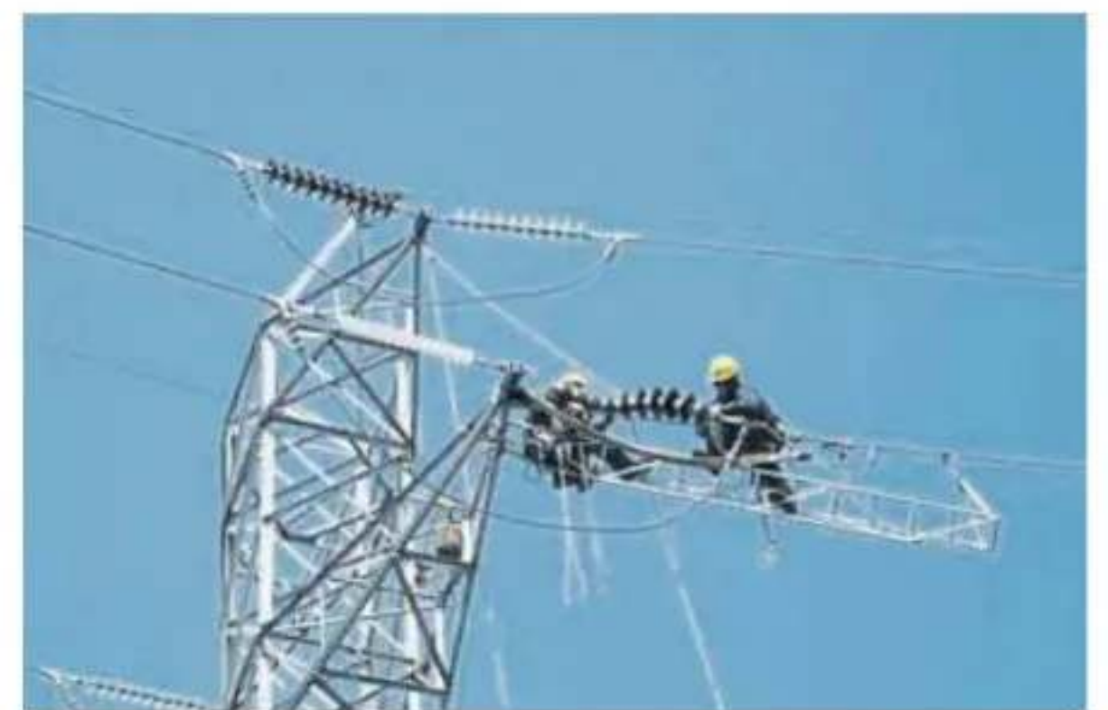
Operarios de Endesa en una línea de alta tensión
